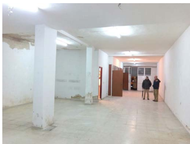
Estado del local antes del acondicionamiento.
