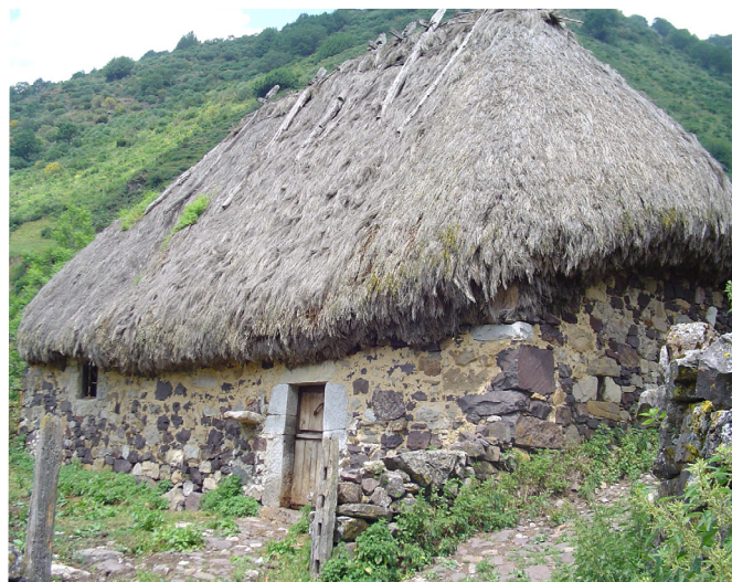
Palloza, también conocida como pallouza y pallaza, es una construcción tradicional de la zona de Somiedo.
